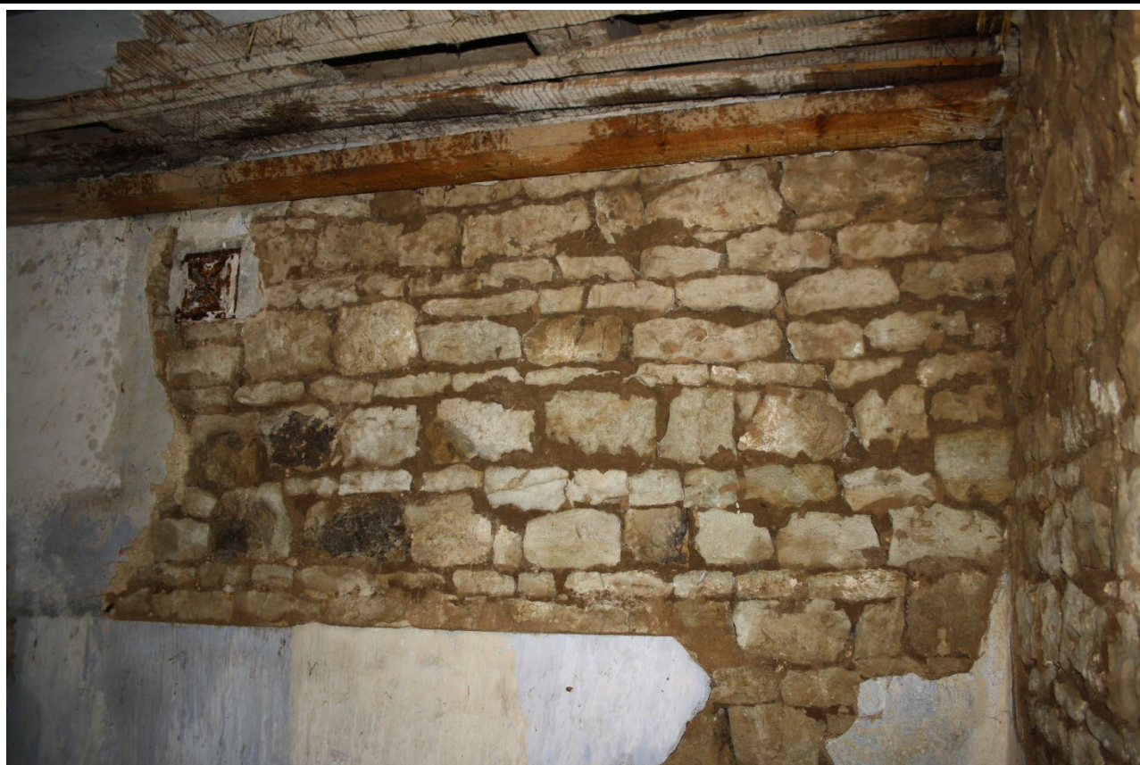
Detail zdiva vrchní partie západní stěny sakristie v pohledu od východu. Foto: Jaroslav Skopec 2015.
