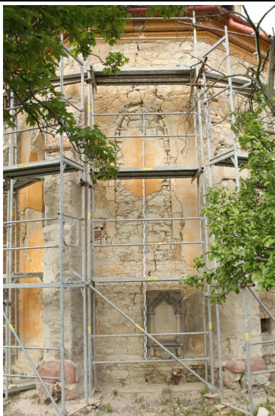
Jihovýchodní pole závěru presbytáře v pohledu od jihovýchodu s patrným zazděným hrotitým oknem. Foto: Jaroslav Skopec 2015.
