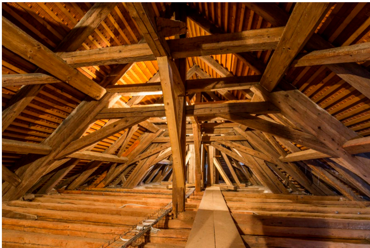
Průhled k východu krovem nad lodí. Foto: Marta Pavlíková 2019.
