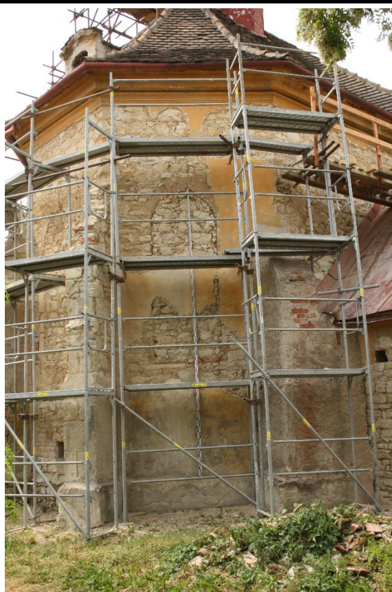
Severovýchodní pole závěru presbytáře v pohledu od severovýchodu s patrným zazděným hrotitým oknem. Foto: Jaroslav Skopec 2015.
