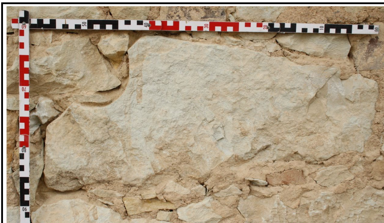
Čelní pohled na díl středověké korunní římsy nacházející se v nadezdívce presbytáře. Foto: Jaroslav Skopec 2015.
