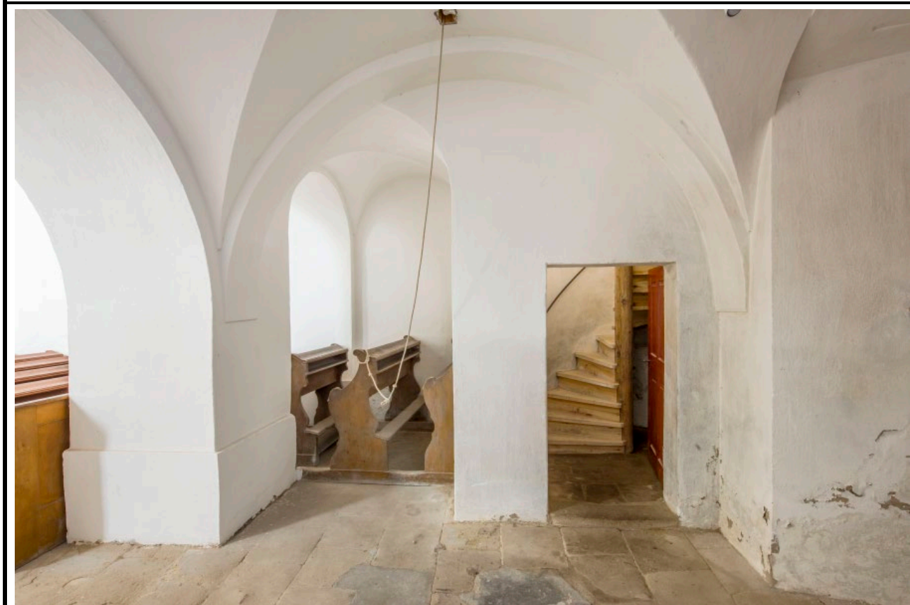
Jižní strana podkruchtí se vstupem na točité schodiště v pohledu od severu. Foto: Marta Pavlíková 2019.
