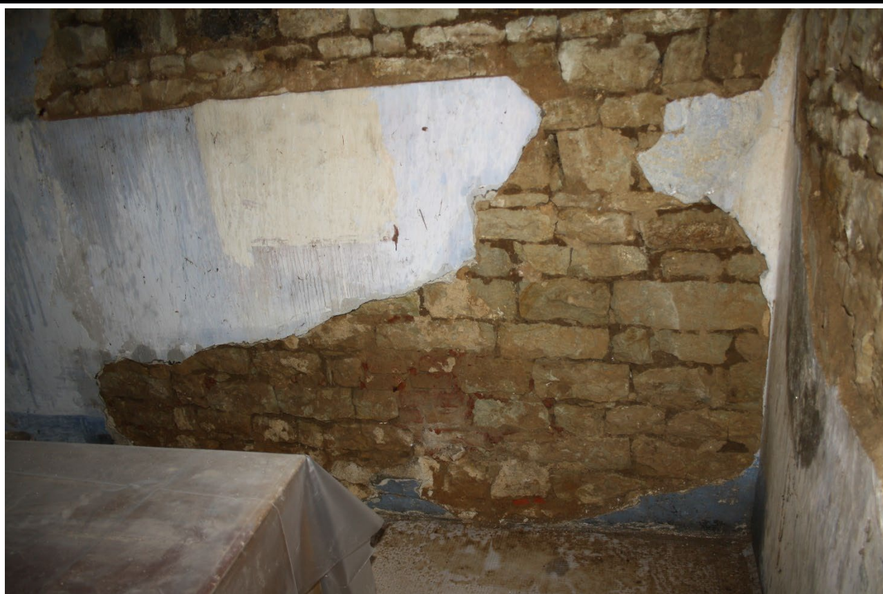
Detail zdiva spodní partie západní stěny sakristie v pohledu od východu. Foto: Jaroslav Skopec 2015.
