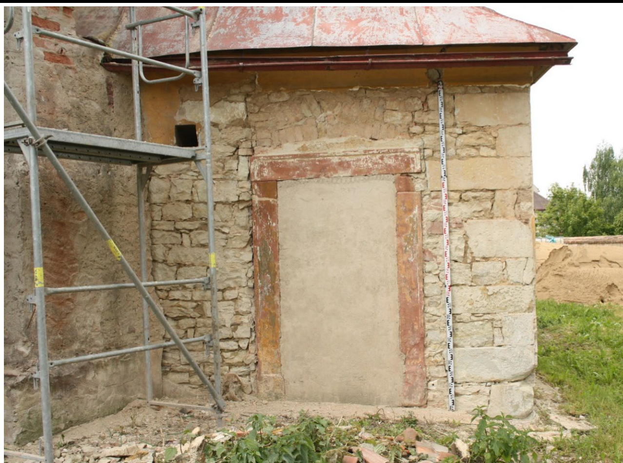
Východní průčelí sakristie v pohledu od východu s patrným armováním severovýchodního nároží. Foto: Jaroslav Skopec 2015.
